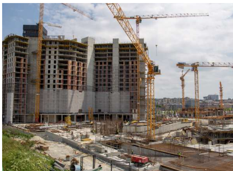
Chantier de construction
