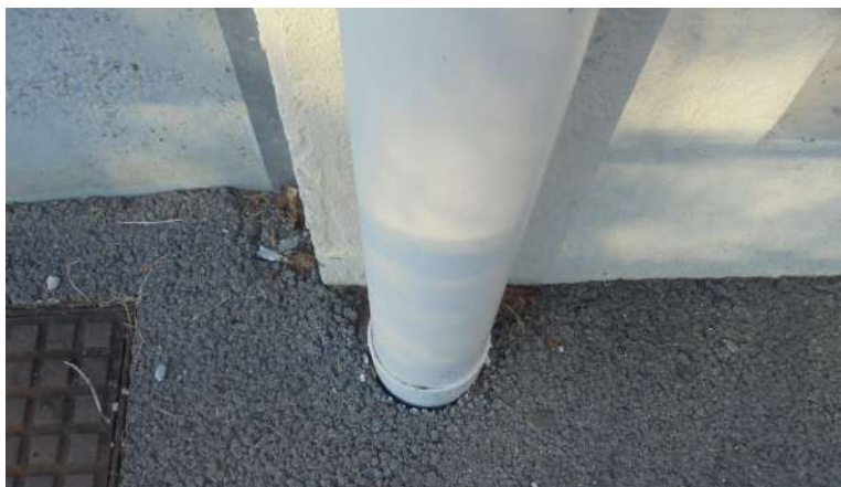
Exemple d'une descente de cheneau hermétique
